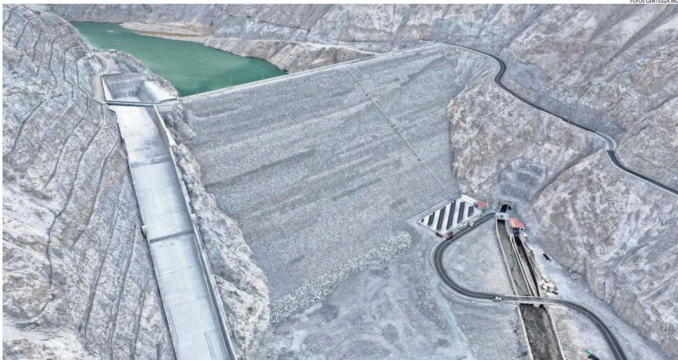
SE ESTÁ DANDO CUMPLIMIENTO A LAS EXIGENCIAS CONTENIDAS EN LA RCA DEL PROYECTO EMBALSE CHIRONTA, COMENTÓ LA DIRECTORA NACIONAL DE OBRAS HIDRÁULICAS DEL MOP, MARÍA LORETO MERY.
