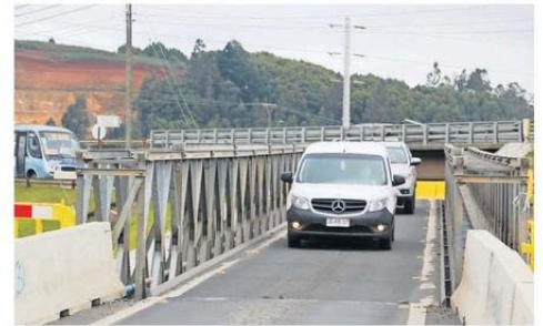
La fecha para el desmonte del puente mecano se anunciará pronto.
