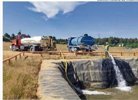
SE HA INSTALADO PISCINAS PARA ACOPIO DE AGUA EN VARIOS SECTORES.
