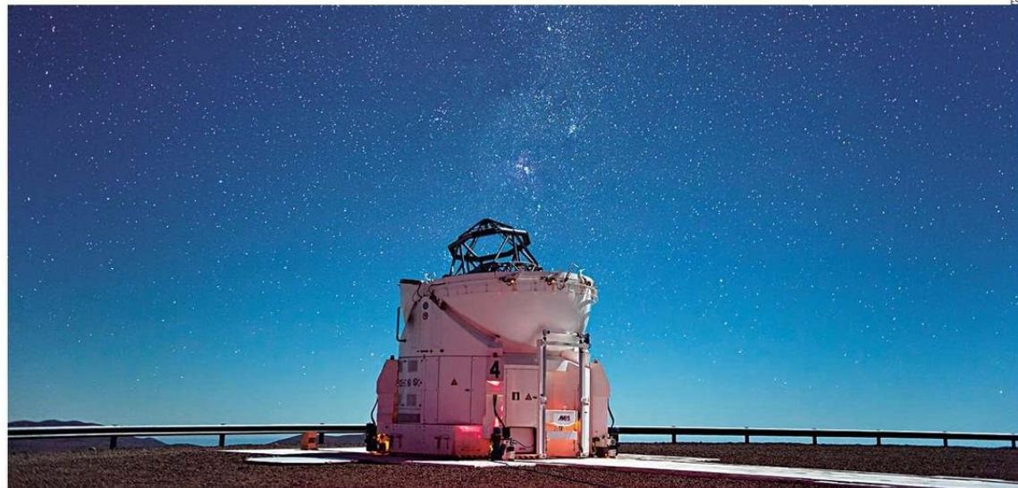
EL PROYECTO SE UBICARÍA A ENTRE 5 Y 11 KILÓMETROS DE LOS TELESCOPIOS DEL OBSERVATORIO PARANAL.
