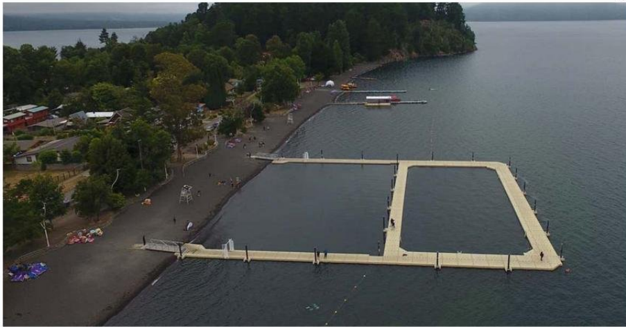
SE INCLUYÓ LA CONSERVACIÓN DE LA PISCINA FLOTANTE EN EL SECTOR DE LICÁN RAY, CAMBIARON LOS MÓDULOS POR UNOS NUEVOS, DADO QUE LOS ANTERIORES SE ENCONTRABAN MUY DETERIORADOS.
