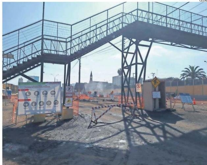
EN LA CARACTERÍSTICA PASARELA PEATONAL DEL SECTOR "PATIO BELLAVISTA SE IMPLEMENTARÁ UNA BARRERA.
