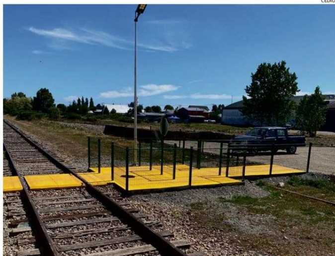
EFE SE COMPROMETIÓ CON LA CONSTRUCCIÓN DE LOS LLAMADOS LABERINTOS DE SEGURIDAD EN CADA CRUCE.
