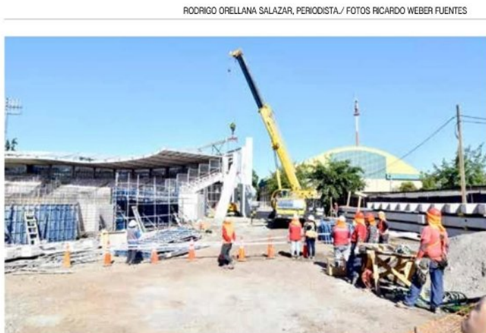
Las obras presentan un 20% de avance.
