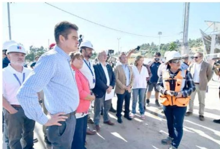
Autoridades visitaron las obras que se desarrollan en el Estadio La Granja.
