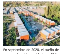
En septiembre de 2020, el sueño de la casa propia se hizo realidad para 50 familias de Salamanca. El proyecto contó con el diseño de la oficina de arquitectos Elemental, en el marco de Somos Choapa.
