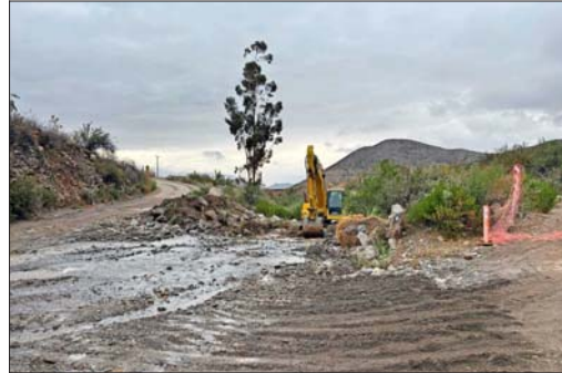
CAUCE.— Las intensas precipitaciones han generado la crecida de ríos.
