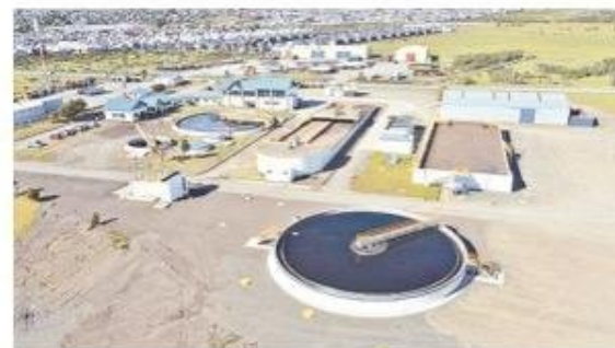
Planta de tratamiento de aguas servidas de Puerto Natales.
