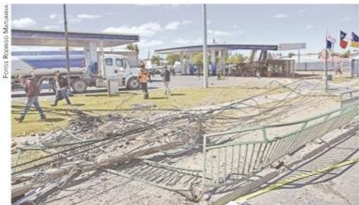
Un tramo de esta reja de protección y un poste del tendido eléctrico destruyó el camión en su descontrolado desplazamiento, para terminar volcado al fondo. En esos precisos momentos un transporte de combustible cargaba los estanques de este establecimiento Copec.
