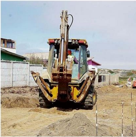
LOS TRABAJOS SE EJECUTAN EN DISTINTOS FRENTES.
