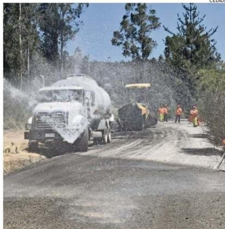
TRAMO PAVIMENTADO ALCANZA LOS 2 KILÓMETROS EN TREHUACO.
