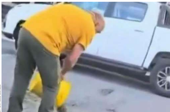
Con sus propias manos y provisto de un balde y arena decidió rellenar los hoyos de calle Chiloé.
