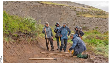
Los trabajos para conectar el Sector Central con el Refugio Chileno, que comenzaron en febrero de 2022, ya están en sus etapas finales.
