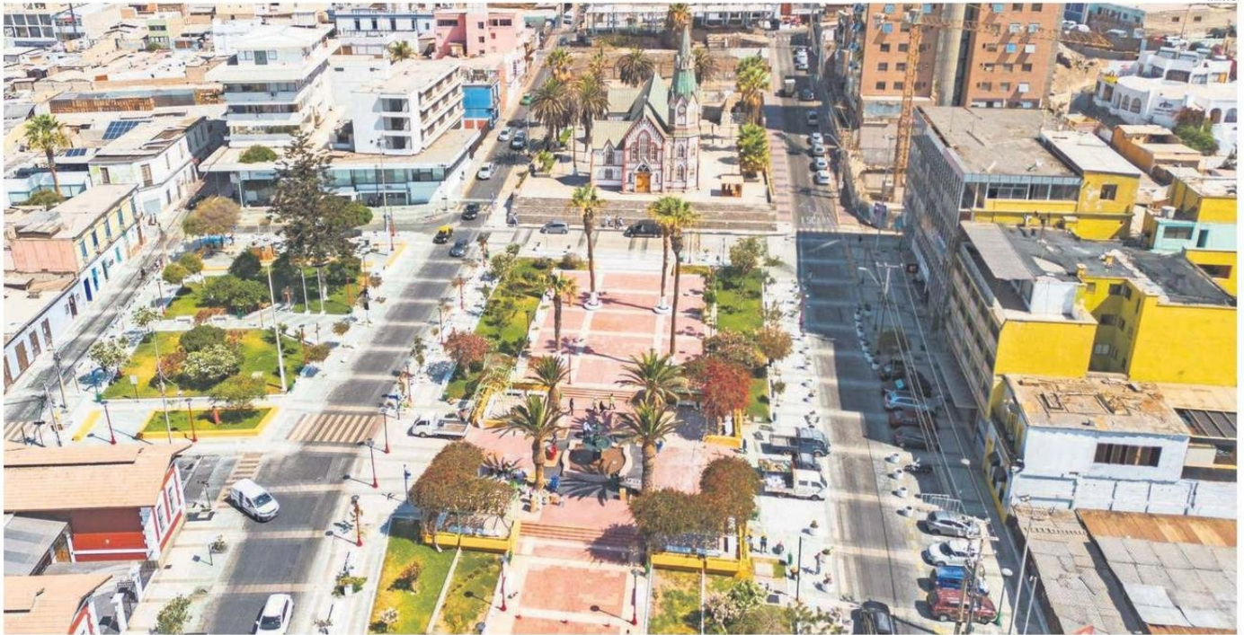
LAS INTERVENCIONES EJECUTADAS SE ORIENTAN AL MEJORAMIENTO DE LOS ESPACIOS PÚBLICOS MEDIANTE LA CONSERVACIÓN DE LAS PLAZAS COLÓN Y LA DEL ROTO CHILENO.
