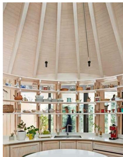
Casa en Nonguén. Estructura de madera laminada Lamitec y revestimientos y puertas de pino *finger*.
