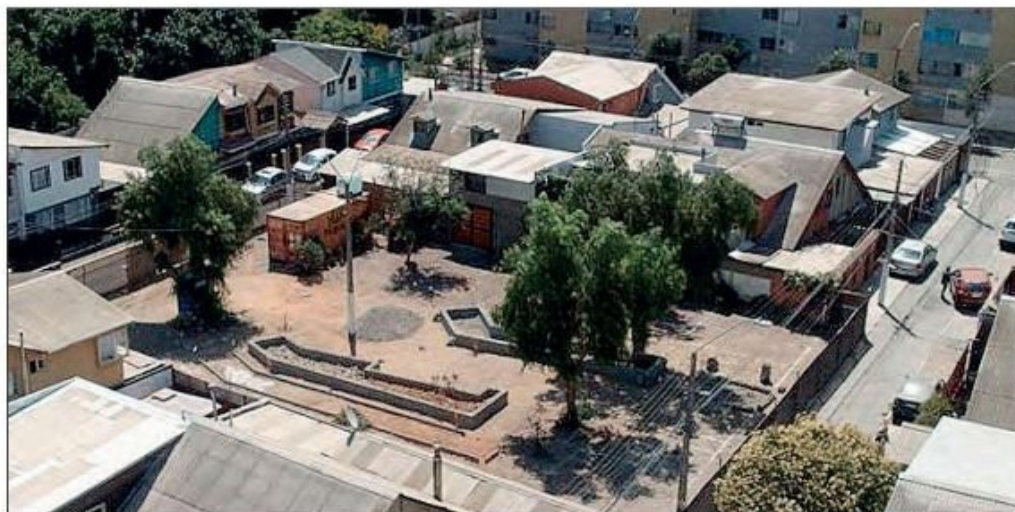
Así lucen las obras en pleno proceso de ejecución.
