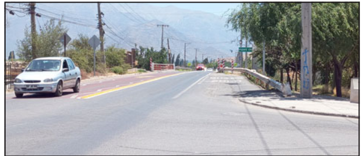
Hoy continuarán las obras en el sector del Puente Encón.
