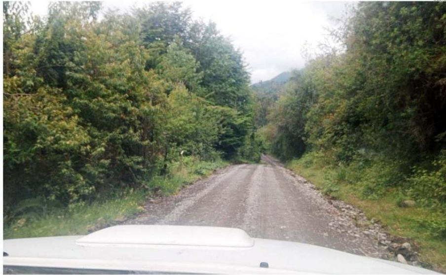
LOS CAMINOS ESTÁN LLENOS DE MALEZAS, ADEMÁS DEL MAL ESTADO, LO QUE DIFICULTA LA VISIBILIDAD DE LOS CONDUCTORES.
