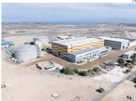
LA PLANTA DE CAP PRODUCE APROXIMADAMENTE 8 MILLONES DE M 3 ANUALES.
