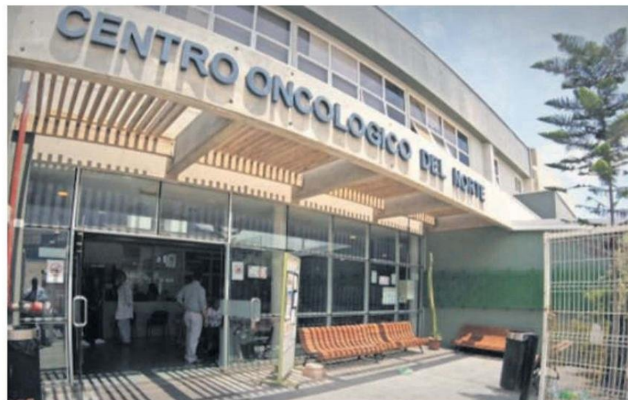
SE HARÁ CAMBIO DE PUERTAS DE TIPO ANTIVANDÁLICAS Y MEJORAMIENTO DEL SISTEMA DE CÁMARAS DE TELEVIGILANCIA.
