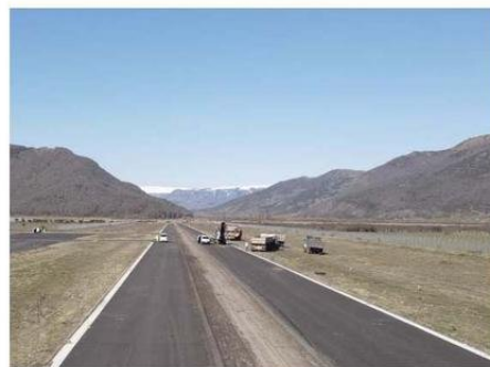
OBRAS REALIZADAS EN AERÓDROMO DE LONQUIMAY.
