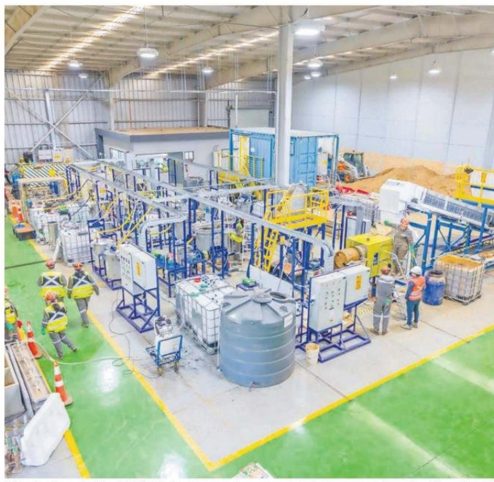
El centro demostrativo del Módulo Penco, proyecto que se encuentra en proceso de evaluación ambiental.
