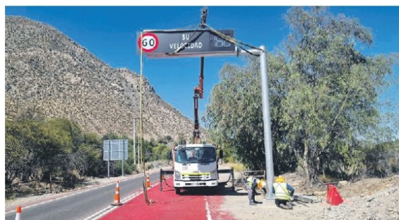
Desde hace unos días se encuentran instalando los radares en la zona. EL DÍA
