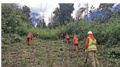
Junto a la comunidad y con todos los recursos en terreno la compañía avanza para asegurar el mantenimiento de su red eléctrica
