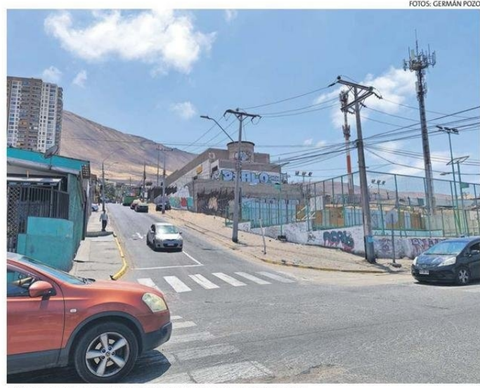
ASÍ LUCE CALLE CASTRO RAMOS SIN SU VEREDA SUR CONSTRUIDA.
