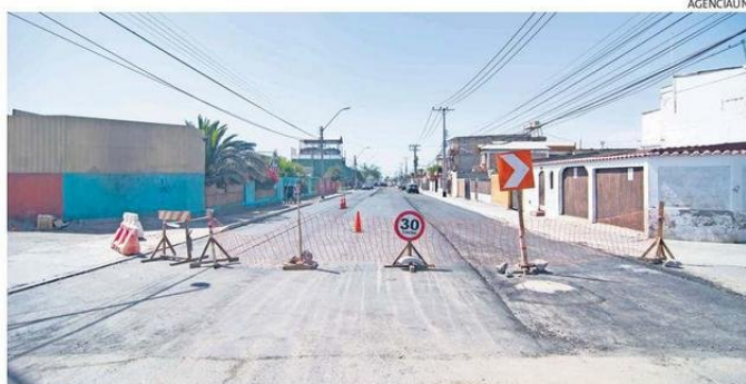
OBRAS SE ENMARCAN EN PROBLEMAS SANITARIOS QUE EL SECTOR HA TENIDO DURANTE 40 AÑOS.
