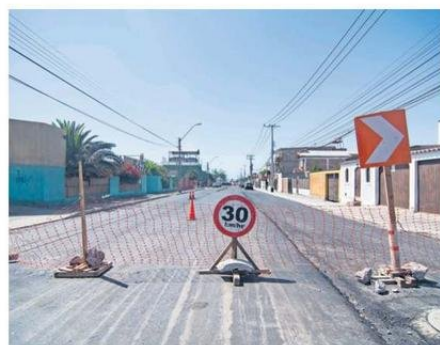
A LA FECHA, FALTA LA CUARTA ETAPA A DESARROLLARSE EN LA OBRA.
