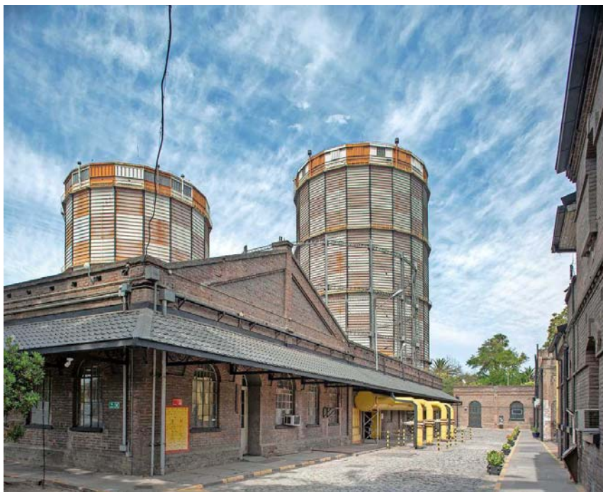
De los tres gasómetros, dos de ellos sobresalen en altura, uno de 75 y el otro de 90 metros. El tercero, de tipo descubierto, es el más antiguo.
