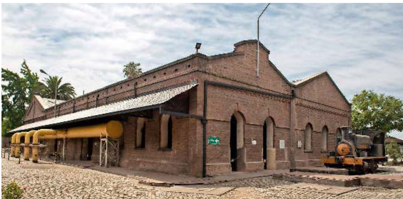
Siguiendo un modelo de arquitectura industrial inglesa, las instalaciones eran de gran calidad constructiva; en el último tiempo fue necesaria una pequeña restauración. La locomotora se usaba para transportar el carbón.
