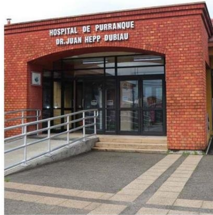
EL HOSPITAL DE PURRANQUE ES UN RECINTO DE MEDIANA COMPLEJIDAD.
