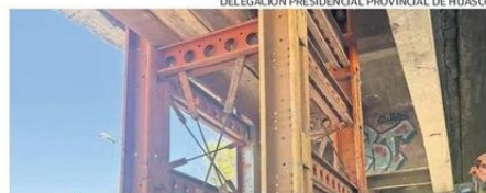
SE INSTALÓ UNA TORRETA PARA SOPORTE DE LA VIGA DAÑADA.
