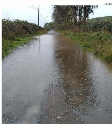
LA LLUVIA INUNDA EL CAMINO CON LÍQUIDOS QUE VIENEN DEL VERTEDERO.
