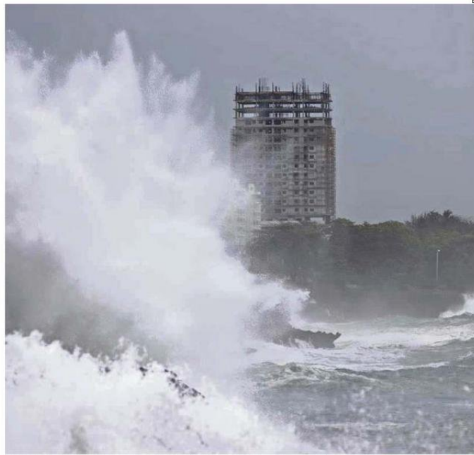
OLEAJES DESMESURADOS PROVOCARON ESTRAGOS Y SOCAVONES EN DISTINTAS LATITUDES.
