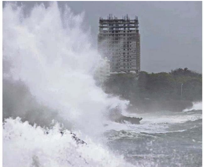
OLEAJES DESMESURADOS PROVOCARON ESTRAGOS Y SOCAVONES EN DISTINTAS LATITUDES.
