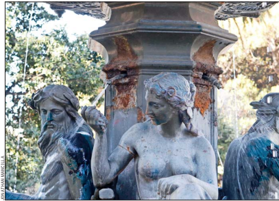
Ahora. Las piezas arrancadas dejaron su marca en la superficie del pedestal de la fuente, quedando a la vista los caños de sus surtidores. La calidad y antigüedad de las piezas se suma a su valor histórico y al carácter patrimonial de la ciudad, por lo que su pérdida se estima como un grave daño para Valparaíso.
