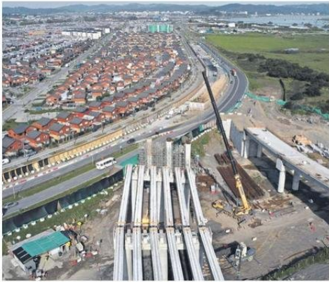
Actualmente el Puente Industrial presenta un 78% de avance.
