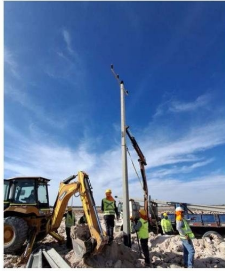
PESE A QUE SE INICIÓ LA REPOSICIÓN, TRABAJOS SE EXTENDERÁN 4 DÍAS.
