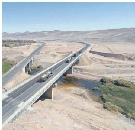
SE HIZO EL CIERRE DE OBRAS DE REPOSICIÓN DEL PUENTE.
