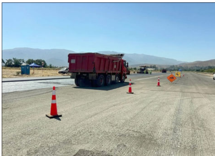
En plena ejecución están los trabajos en el aeródromo Víctor Lafón.
