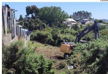
CON MAQUINARIA DESPEJERON PASTIZALES CERCANOS A CASAS.
