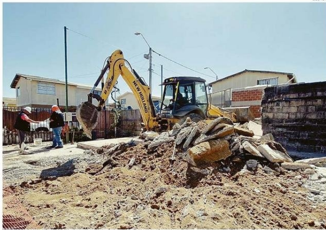
EL VIERNES COMENZÓ EL TRABAJO DE DEMOLICIÓN POR PARTE DE LA CONSTRUCTORA EN EL SECTOR.
