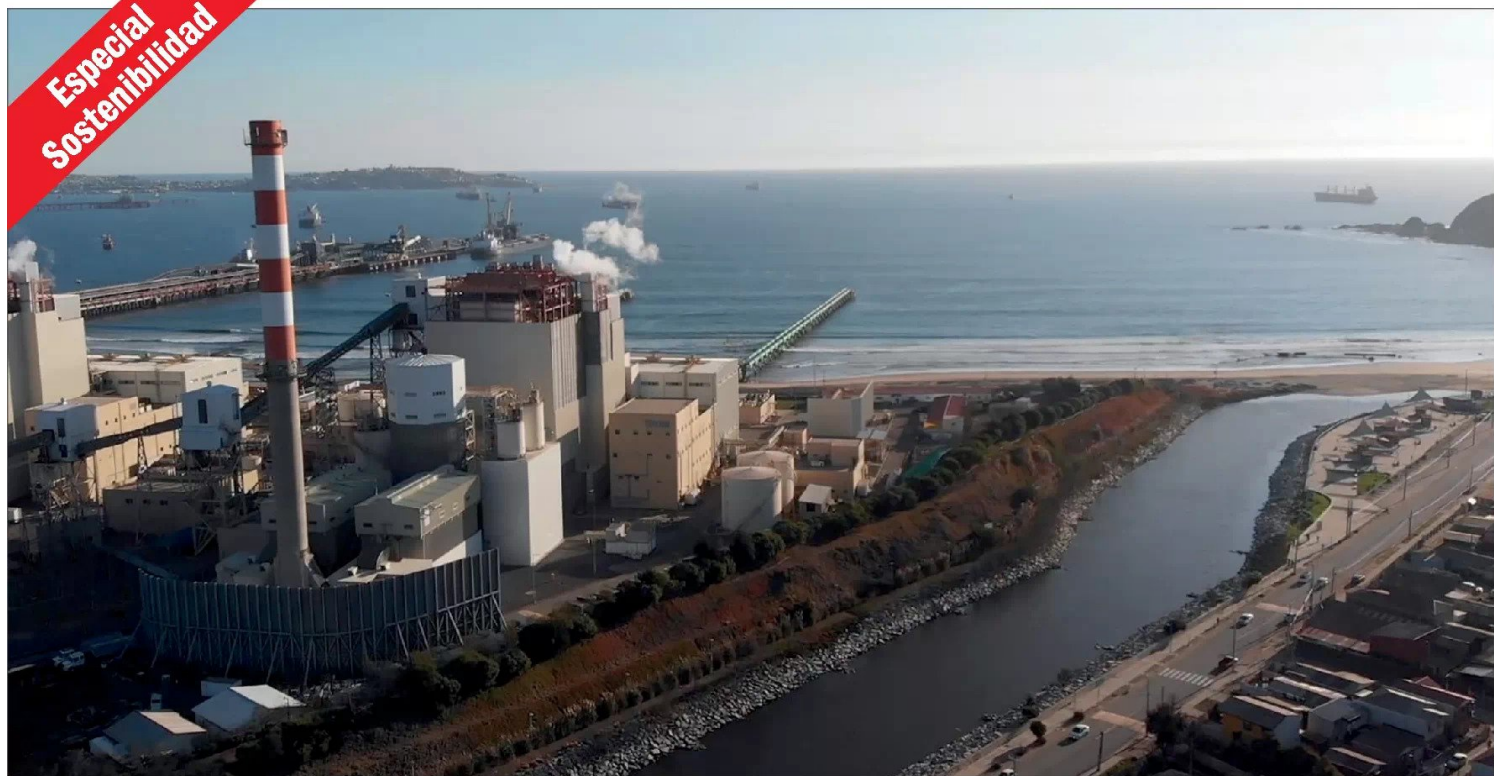
El complejo termoeléctrico Ventanas 2 cesó sus funciones el 31 de diciembre de 2023.
