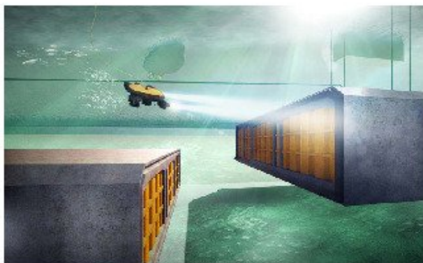
Conexión de dos elementos del túnel bajo el agua del mar. Foto: Femern A/S.
