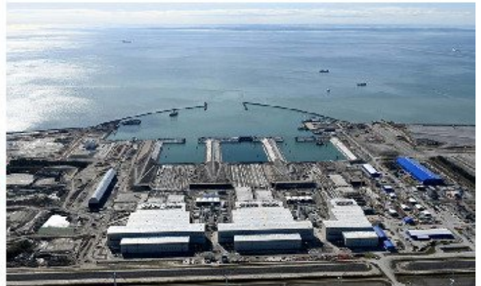
Fabrica de elementos del túnel en zona portuaria de Rødbyhavn. Foto: Femern A/S.
