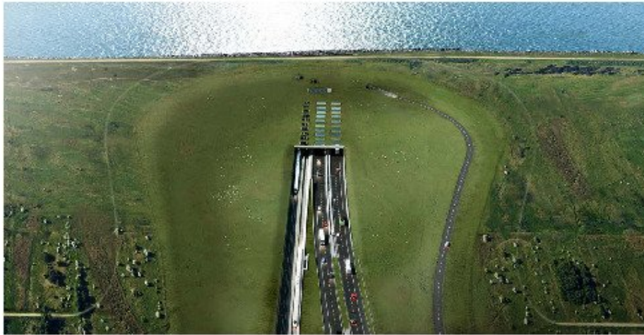
Zona de acceso al enlace al túnel Fehmarn en Dinamarca. Foto: Femern A/S.
