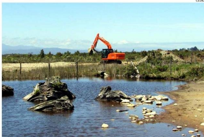
LA CORTE CONCLUYÓ QUE EN EL SECTOR HUBO REMOCIÓN DE TIERRA, DE VEGETACIÓN Y ESCARPE DE TERRENO.
