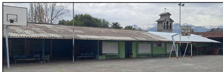
En las próximas semanas comienzan las obras en la Escuela José de San Martín.
