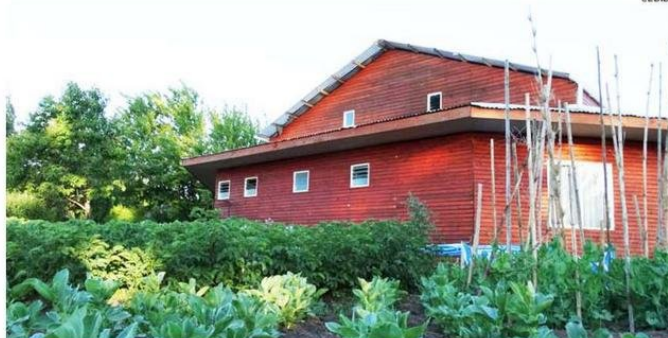
LA RESIDENCIA CUENTA CON ESPACIOS COMUNITARIOS. SE UBICA EN EL SECTOR DE MAILE, A 40 KM. DE OSORNO.
