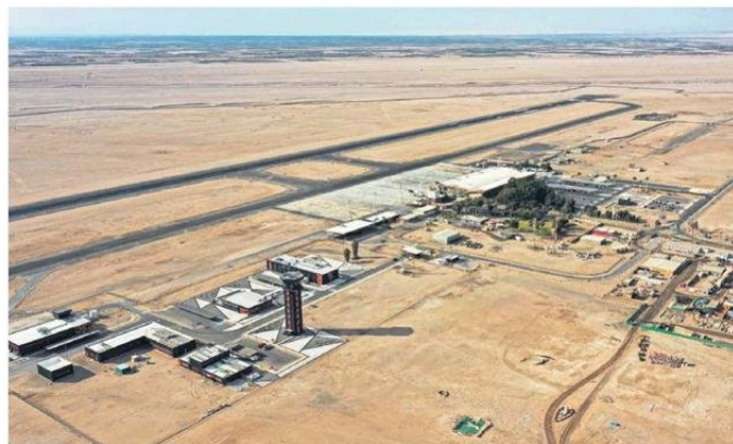
SE CONSTRUYERON UNA NUEVA TORRE DE CONTROL Y 5 PUNTES DE EMBARQUE, ENTRE OTRAS OBRAS.
