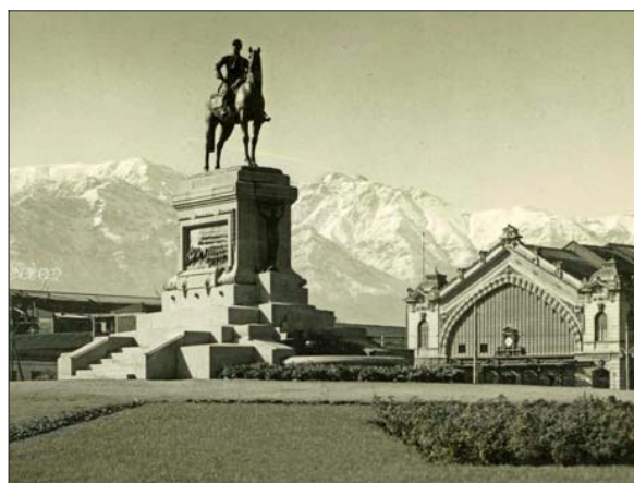
La estación de ferrocarriles Pirque funcionó hasta 1941 y fue demolida dos años después.
