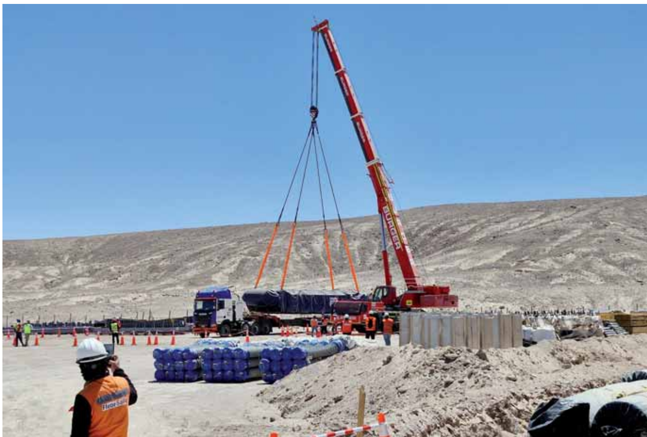
❖ Llegada de equipos críticos a faena.
